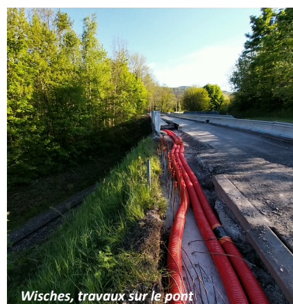
Wisches, travaux sur le pont
